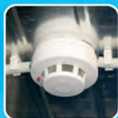
Датчик системы пожарной сигнализации
